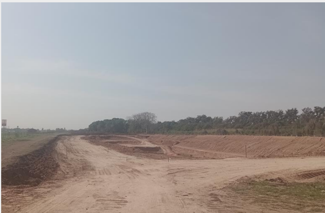
Imagen 1: Construcción de área de vuelco en Centro Ambiental (Predio Sucre)
